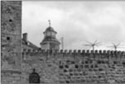
Burgmauern von Südwesten.
