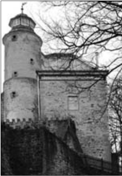
Schloss Ortenberg, Turm von 1500 und Küchenbau von 1800 nach Nordosten.
